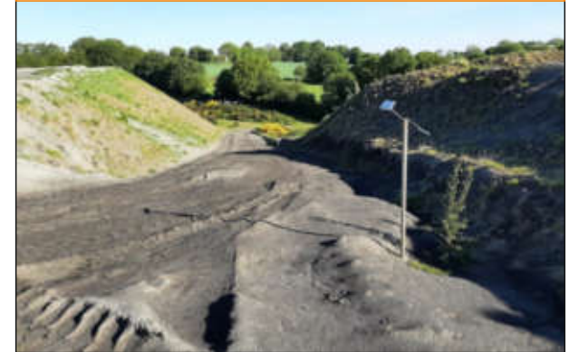
Conduite de gaz enterrée et balisée après le poste de livraison (2)
