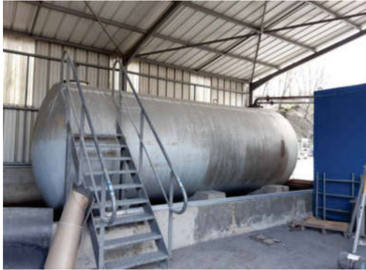
Cuve GNR magasin: 30 m 3 (engins sur roues)
