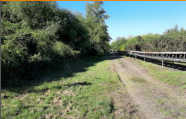
Conduite de gaz enterrée longeant la piste et le convoyeur
