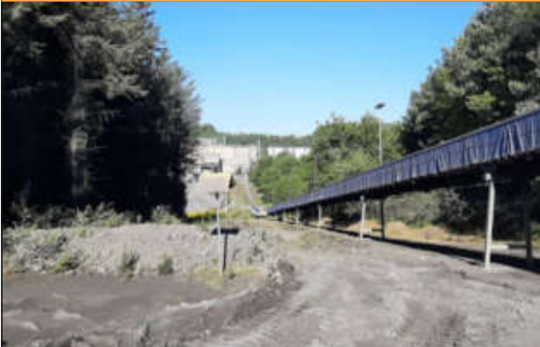
Conduite de gaz enterrée et balisée longeant le convoyeur à l'arrivée de l'usine
